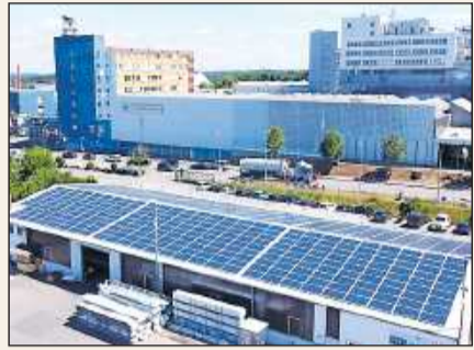
Mit Fotovoltaikanlagen will sich Profine weitgehend unabhängig beim Thema Energieversorgung machen. FOTO: HOFFNER
