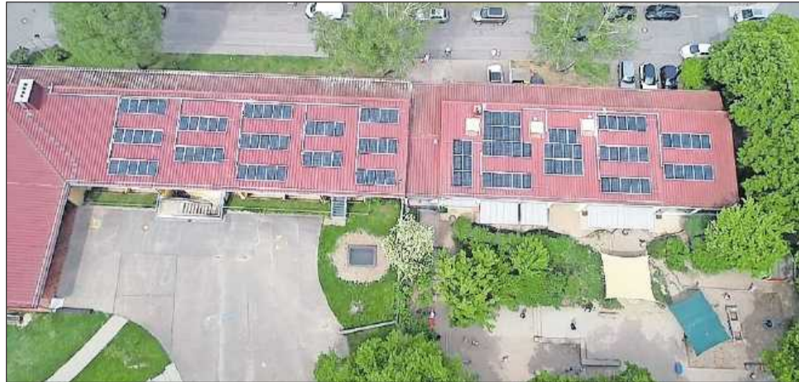
Die Fehrbacher Grundschule hat eine Fotovoltaikanlage bekommen. Wegen der Dachstatik jedoch nicht auf der gesamten Fläche. FOTO: STADTWERKE
